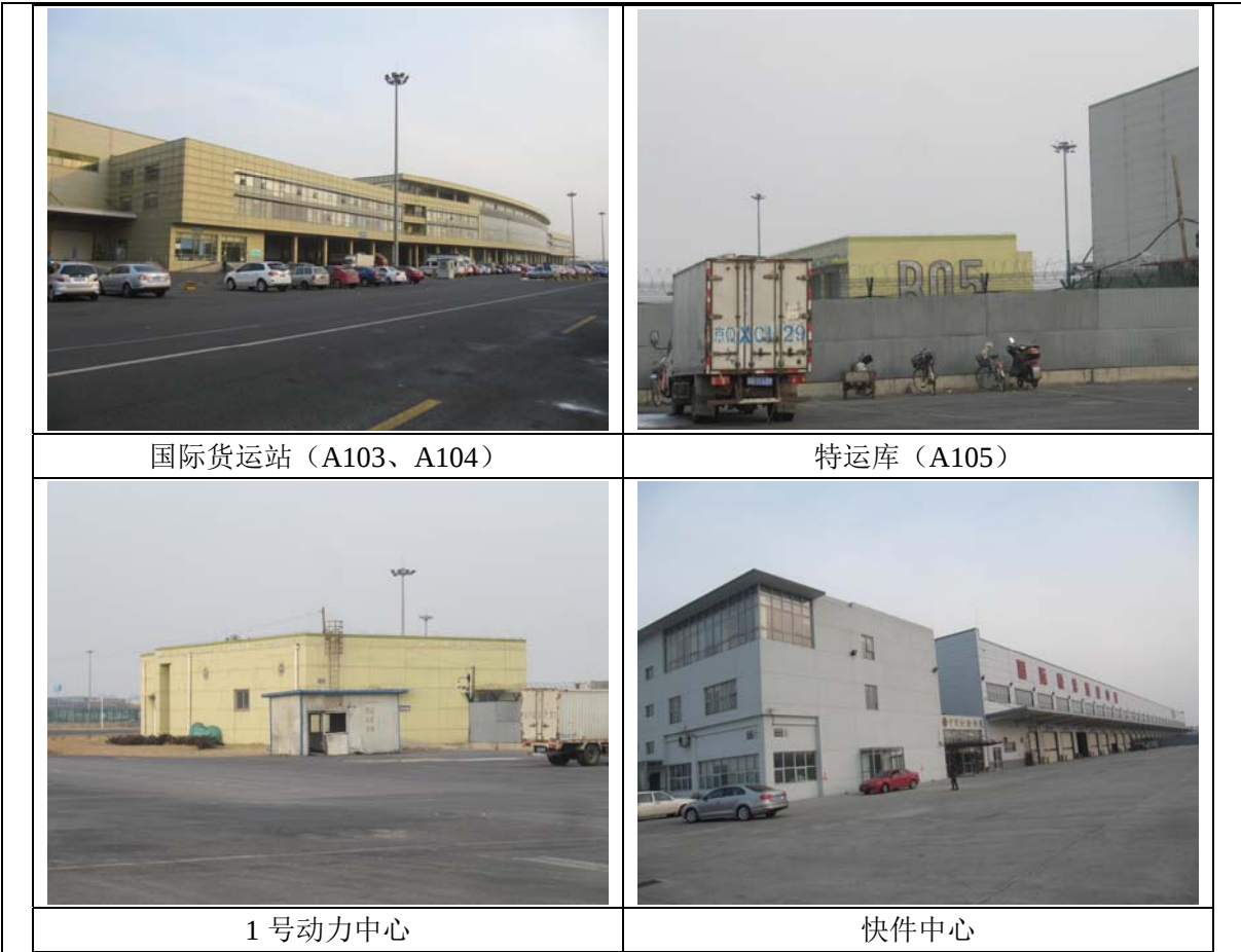
图 1 工程主要构筑物照片
