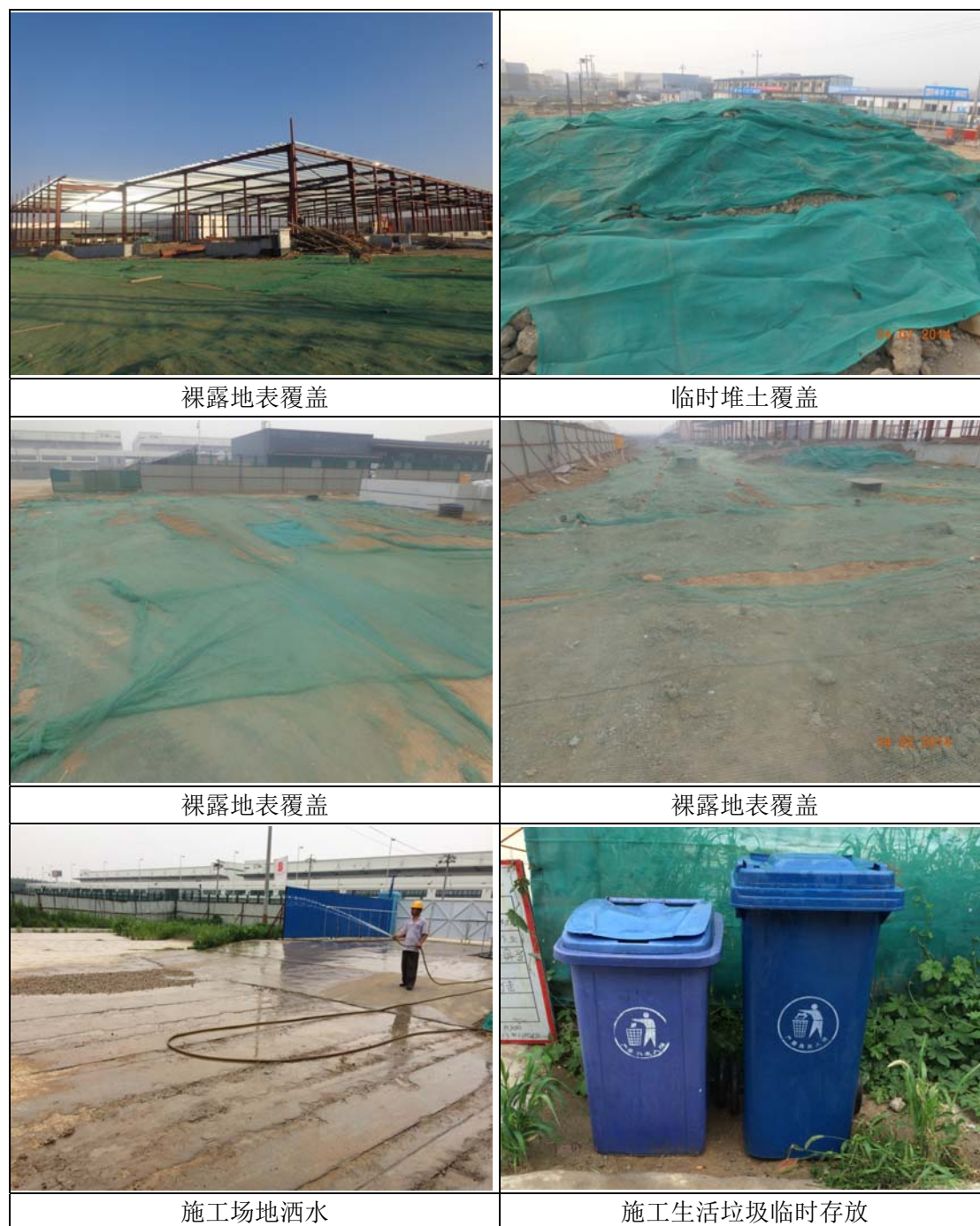
图 2 施工期环保措施照片
