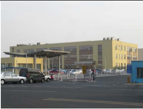
海关查验中心及海关办公楼
