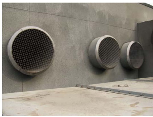
南楼锅炉烟囱
