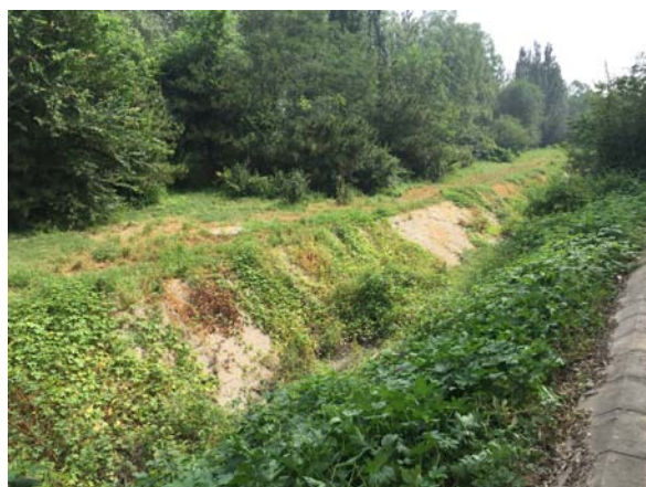
项目穿越明沟
