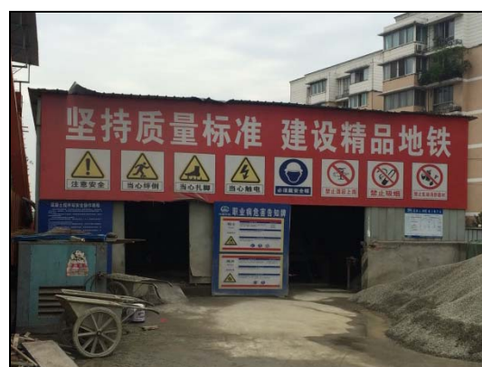
混凝土搅拌位于封闭搅拌棚内
