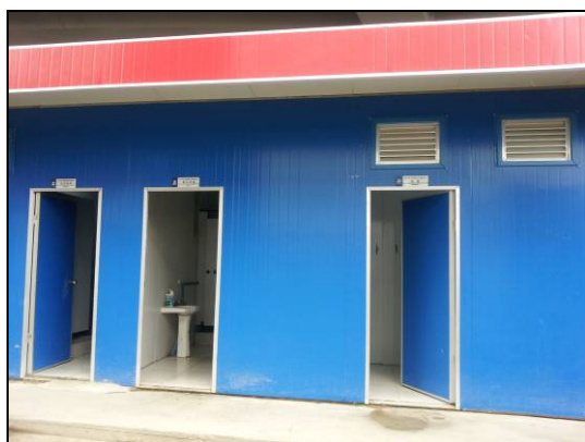
施工营地卫生间
