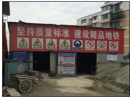
混凝土搅拌位于封闭搅拌棚内
