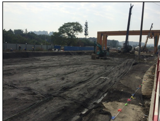
裸露地表覆盖
