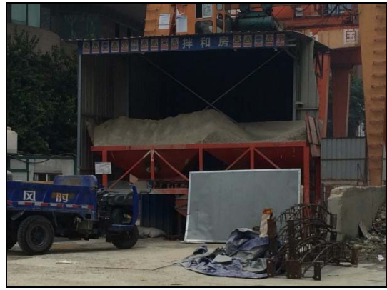
砂石料拌和位于半封闭拌和房内
