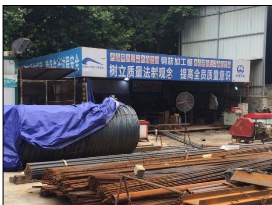
钢筋等加工置于半封闭加工棚内
