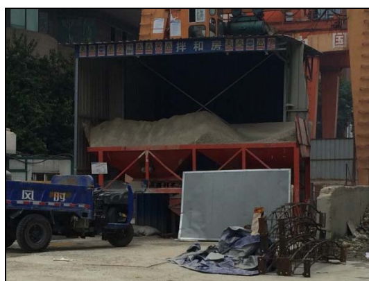
砂石料拌和位于半封闭拌和房内
