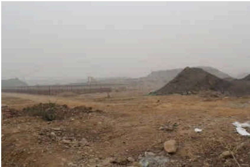
照片 2.6.7-2 项目临时堆土场现状
