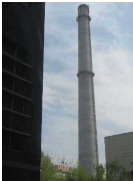
北、西锅炉房烟囱现状
