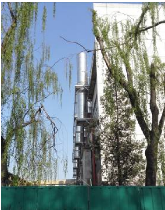
南锅炉房现状
