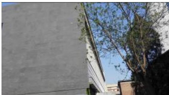
北锅炉房现状
