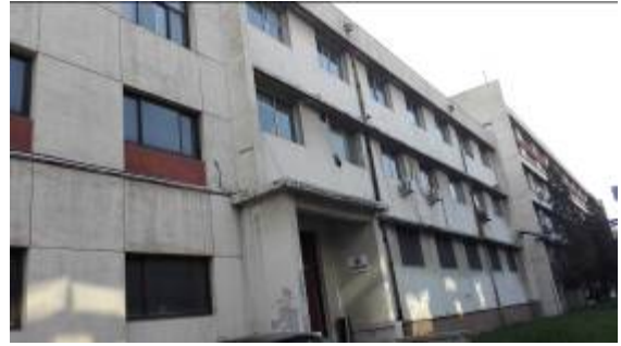
6kV 配电室现状
