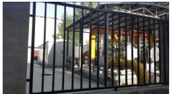
燃气调压站现状
