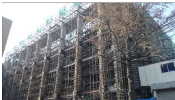
西锅炉房现状（加固中）
