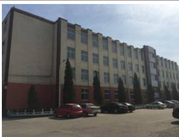
锅炉房西南侧教学楼
