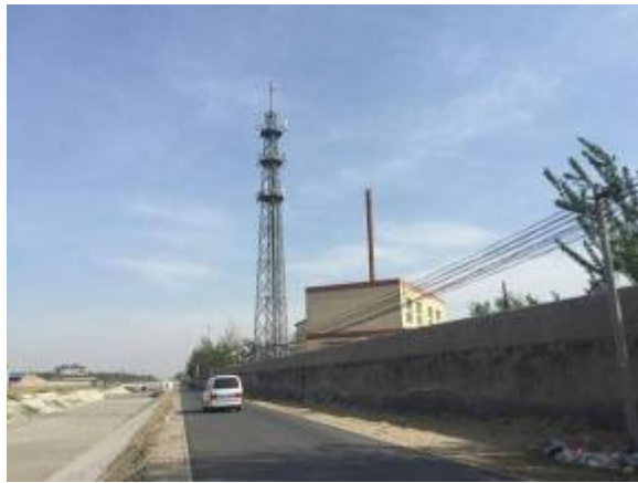
锅炉房东侧校区围墙及校区外道路
