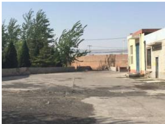
锅炉房西侧煤场
