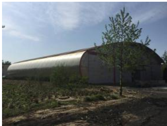
锅炉房西侧实习楼
