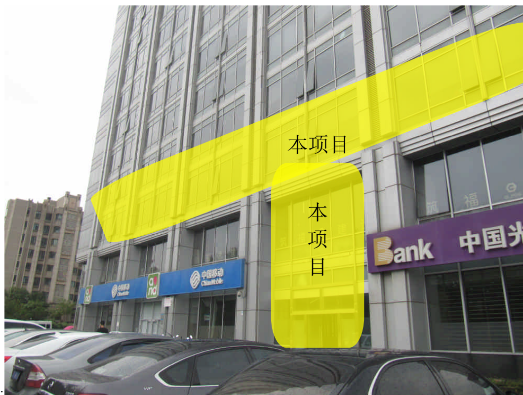
图 2.1-4 本项目所在泽洋大厦现状照片
