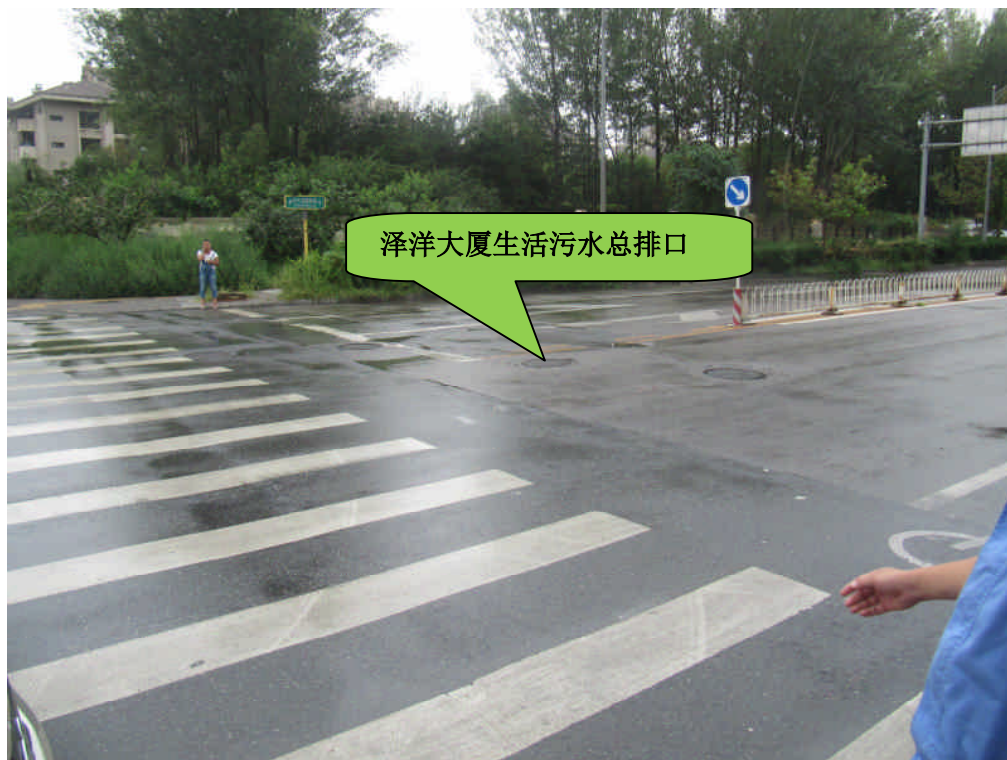
图2.1-6 位于大厦东侧的时代花园西街中间的泽洋大厦生活污水总排口
