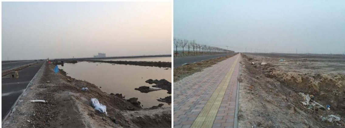
嘉顺道已实施段现场照片（西侧路幅）
