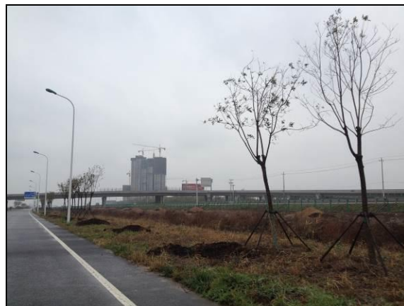
图 15 阳光海岸小区（正在施工）
