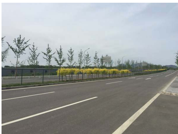
北侧云岗西路
