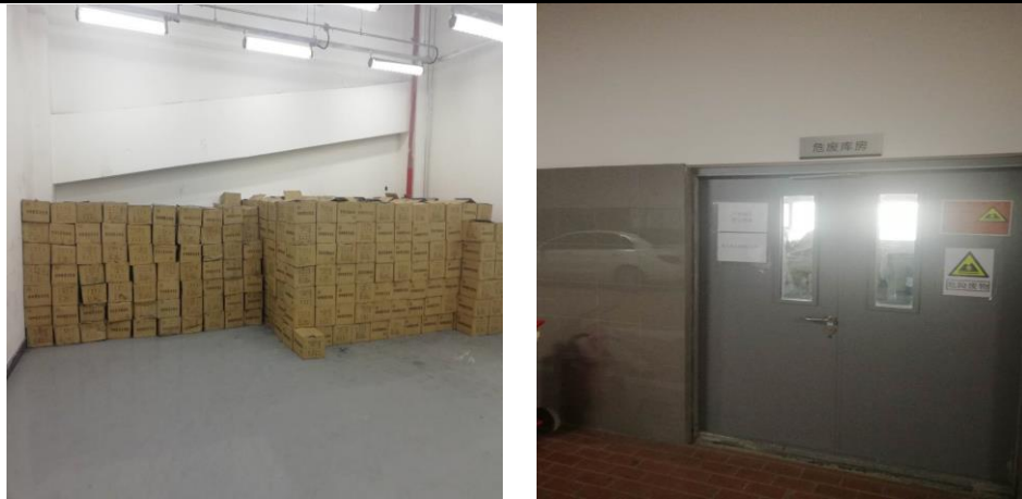
图 9 项目危废存储间
