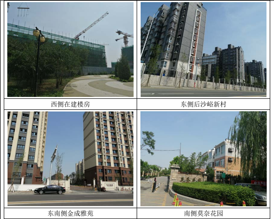
图 1-1 项目周边现状照片
