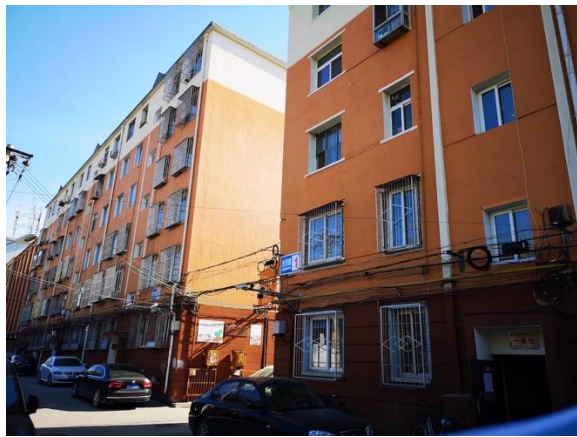
西侧胜芳园小区
