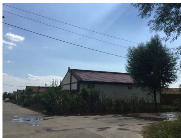
LNG 瓶组气化站南侧平房
