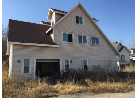
项目用地内待拆木屋
