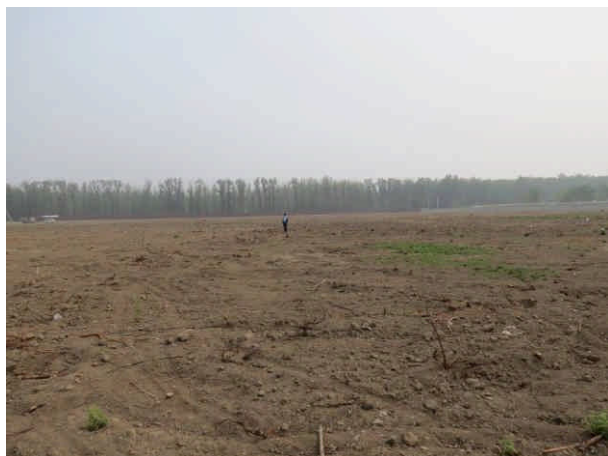
已平整待建地
