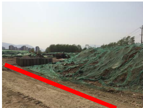
终点（核心区东侧路处由东向西）
