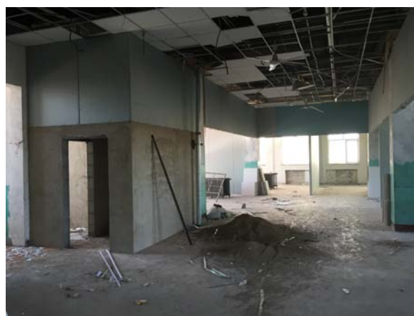
项目所在建筑（内部）
