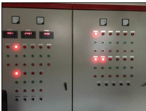
现有污水处理站控制室
