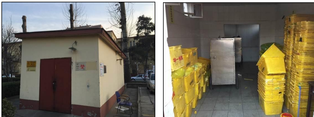
现状医疗废物暂存间（拟拆除）
