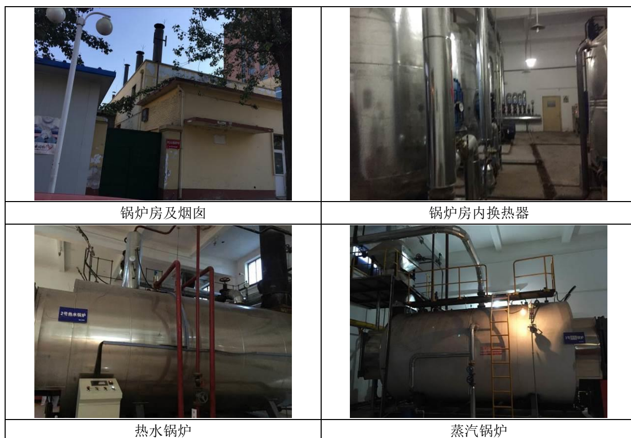
图 2.2-1 现有锅炉房照片
