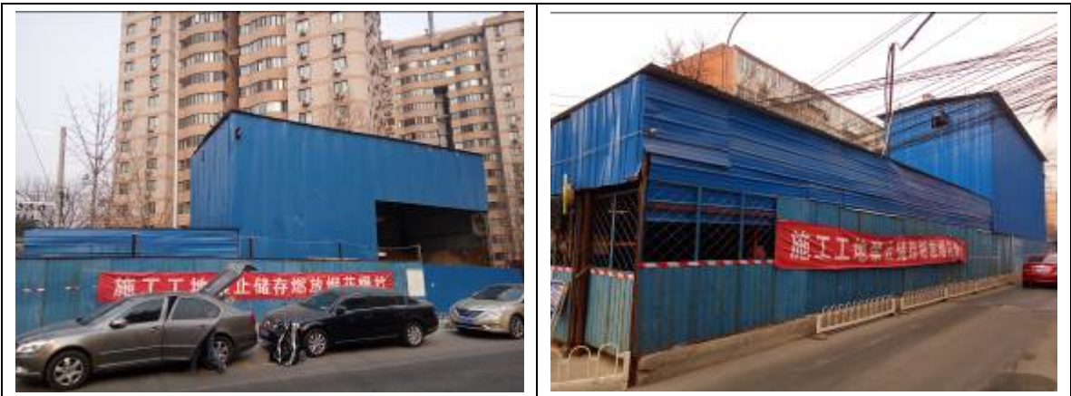
图 7.1 静安东街热力管线工程临时施工竖井防护工棚现场施工图
