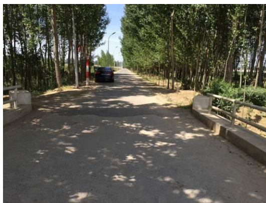
图 2.6-2 凤港引渠路照片
