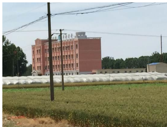
高村镇第二小学现状照片
