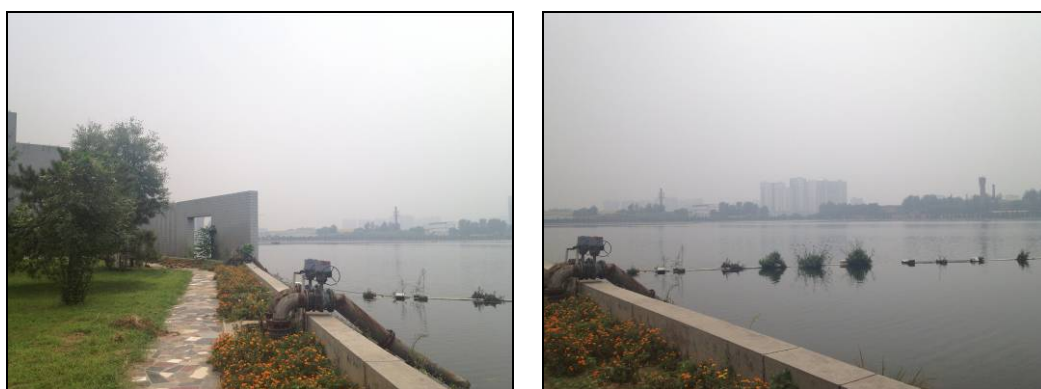
图 4.2-1 碧水污水处理厂照片实景
