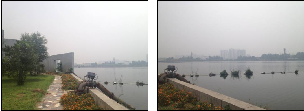
图 4.2-1 碧水污水处理厂照片实景
