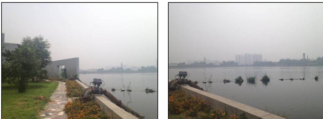
图 4.2-1 碧水污水处理厂照片实景
