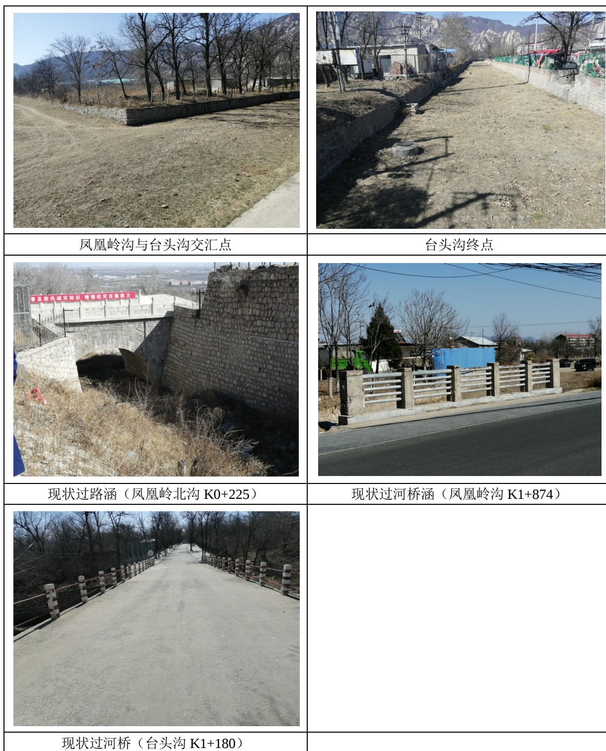
图 3.1-2 项目河道现状照片
